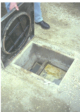
Bac à graisses de petite taille enterré [doc. COSTIC] Bac à graisses dans un local en sous-sol [doc. COSTIC]
